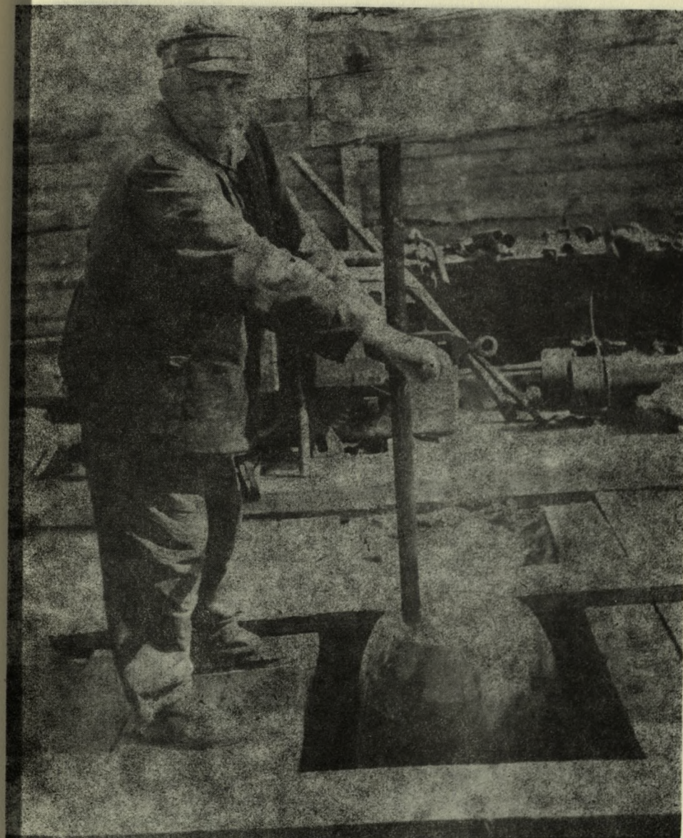
20. Budowa ujęcia wodnego na stacji wodociągowej w 1952 roku. Ręczne wiercenie studni nr 9.
