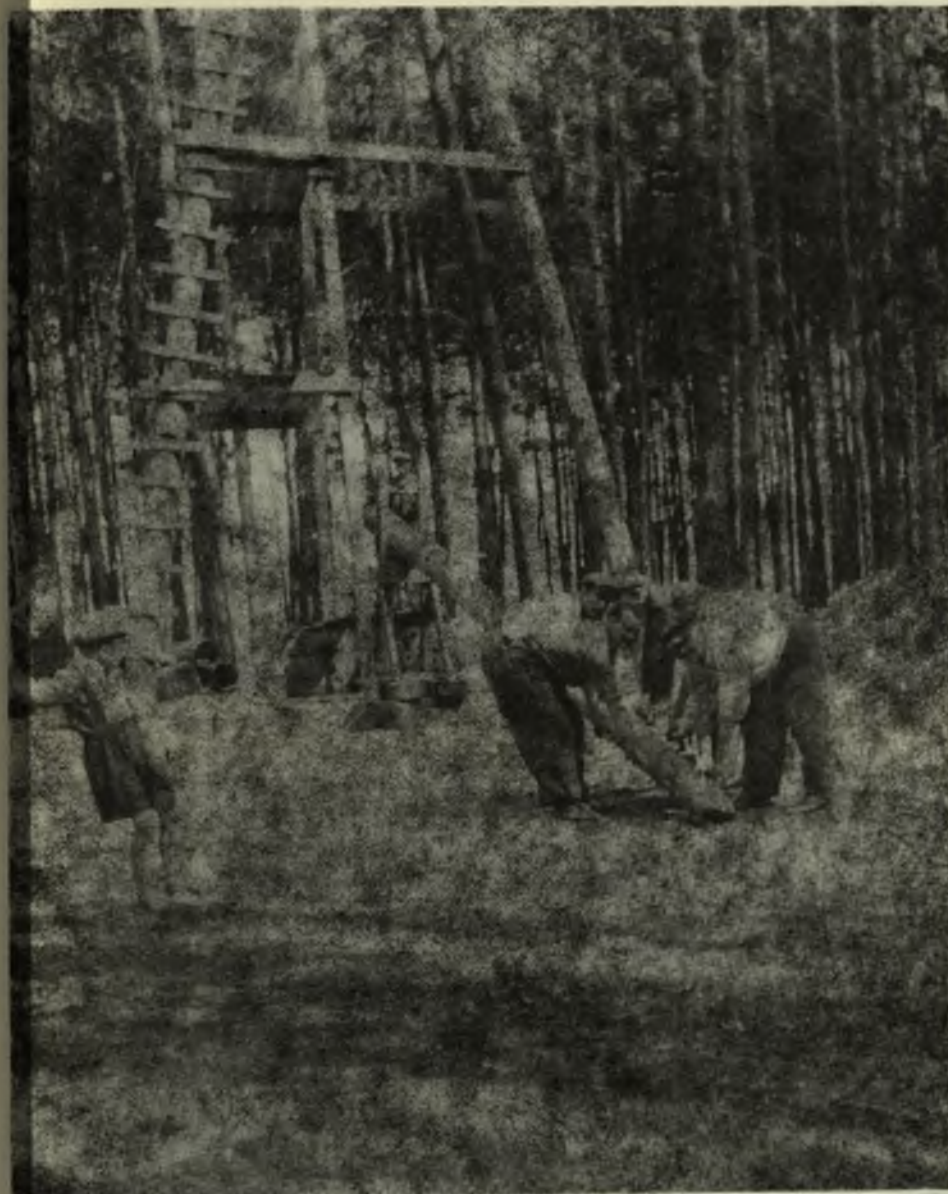
21. Wiercenie studni nr 6 na stacji wodociągowej w 1955 roku.
