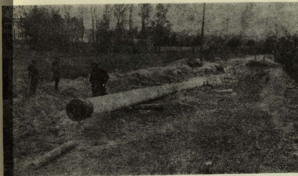
18. Budowa wodociągu w 1941 roku.
