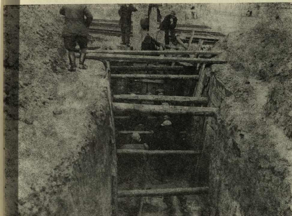
16. Budowa rurociągu \Phi 200 mm pod przejazdem lubelskim w 1936 roku.
