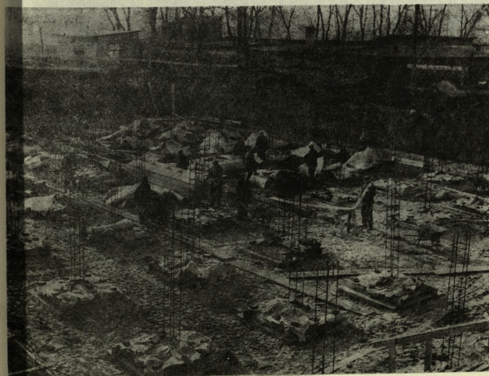
19. Budowa drugiego zbiornika czystej wody na stacji wodociągowej w 1953 roku.
