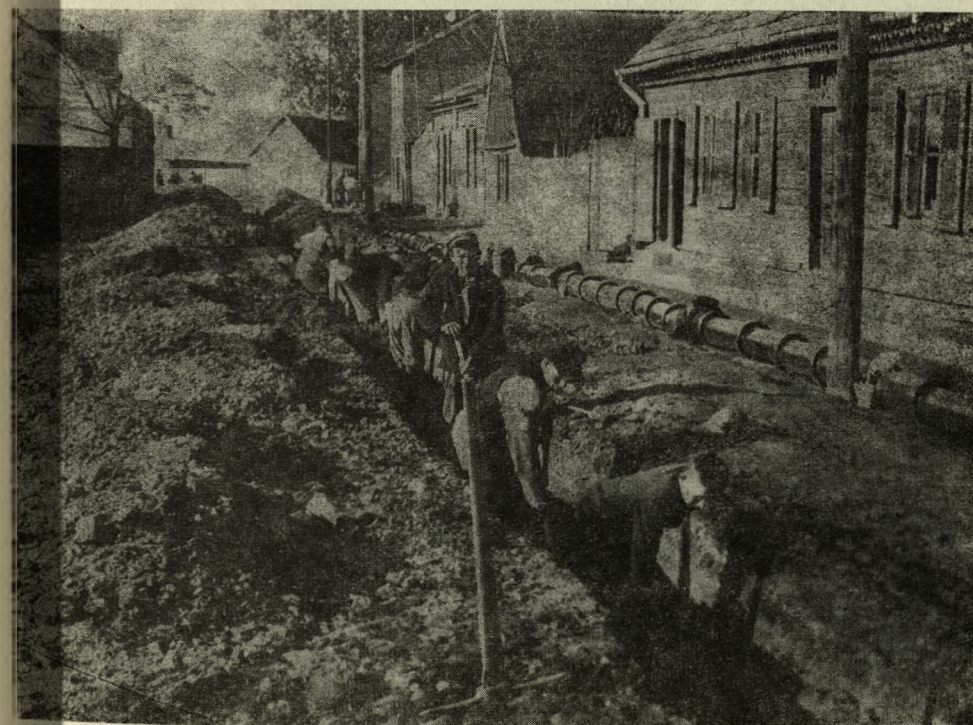
17. Budowa kanału sanitarnego na ulicy Strzeleckiej w 1937 roku.
