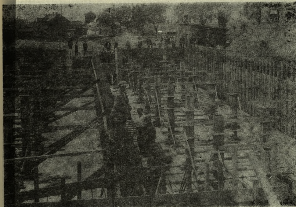
9. Budowa zbiornika czystej wody (zbrojenie) w lipcu 1923 roku.
