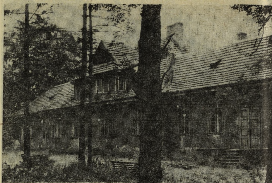
Budynek dawnego szpitala św. Zygmunta w Radomiu, ul. Zielona (budowany w latach 1926—1927), dawny oddział chorób zakaźnych obecnie mieści się w Wojewódzkim Szpitalu Zespolonym
