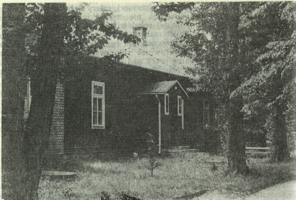
Dawny budynek szkoły powszechnej, obecnie przedszkola
