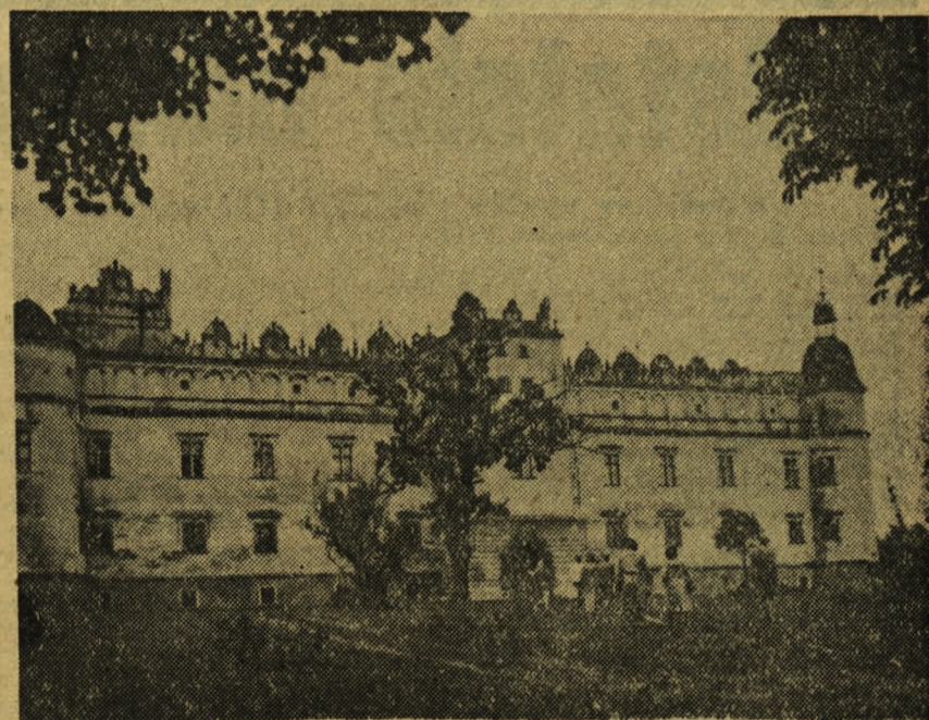
Romańszczyzna, gotyk i renesans to najczęściej spotykane typy budowli zabytkowych w Kieleckim. Z troskliwością i pietyzmem odbudowuje się je, przywracając wygląd zniekształcony rozmaitymi przeróbkami. Oto wspaniały pałac w Baranowie z 4 basztami i ładnie ukształtowaną attyką. Zbudował go wojewoda lubelski, Andrzej Leszczyński, w początkach XVII wieku. (Do reportażu na str. 4). (Foto Ibis).
