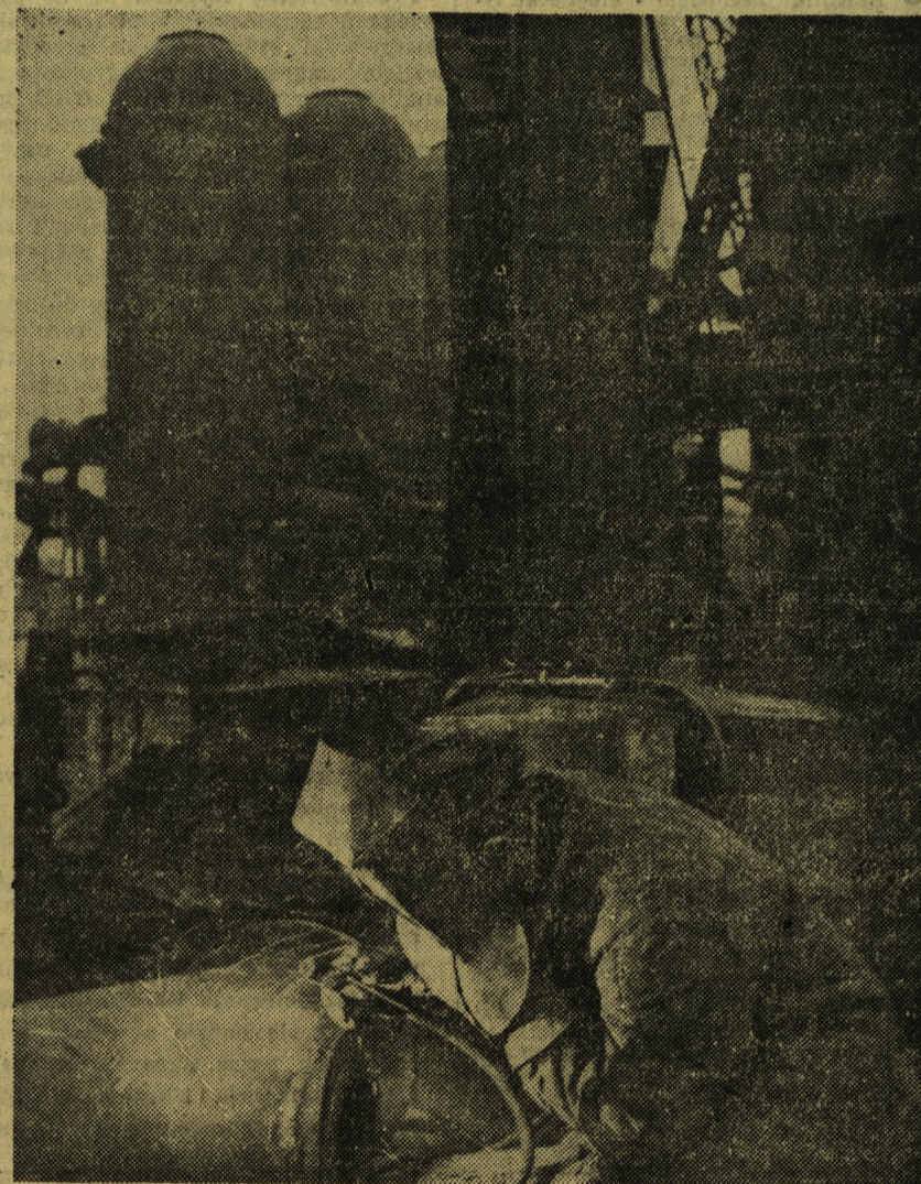
Stalowy kolos Huty Kościuszkowskiej, wielki piec „B”, zyskuje sąsiada i równie potężnego bliźniaka, piec „C”. Podczas gdy rozpalano ogień w paleniskach pieca „B”, budowniczość rozpoczęła wznoszenie nowej, ważnej jednostki hutniczej. Stara i wystuzona huta Kościuszkowska przeżywa swą drugą, o ile wspanialszą młodość.
